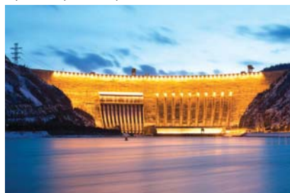
Саяно-Шушенская ГЭС Красноярский край
