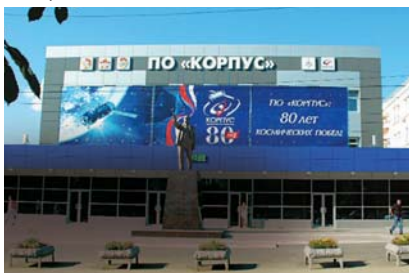
Реконструкция цехов ФГУП ПО «Корпус» г. Саратов
