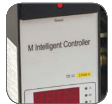
Микропроцессорный расцепитель с селективной программируемой защитой
