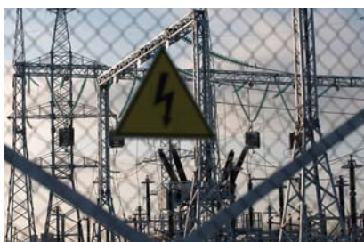
Реконструкция трансформаторной подстанции г. Севастополь
